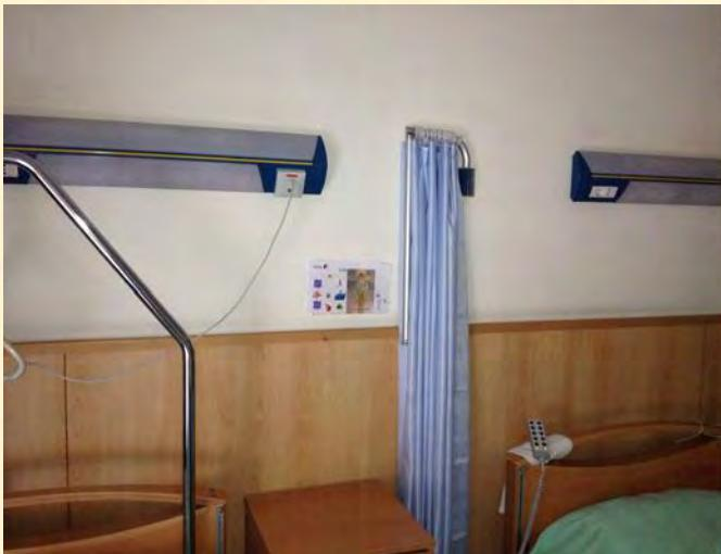
Struttura telescopica orientabile a 180° e pieghevole a 90° tramite snodo in alluminio con un'estensione max a 2200 mm, completa di 17 anelli in nylon e fermanello per garantire un facile utilizzo.
